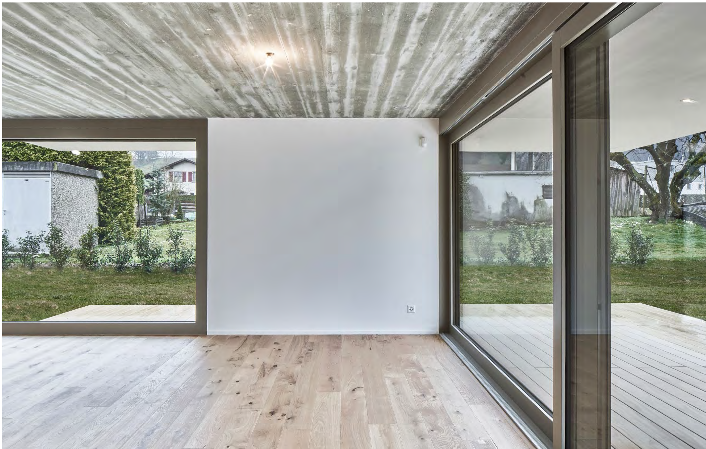
wohnbereich mit sichtbetondecke in sägeroher brettstruktur
